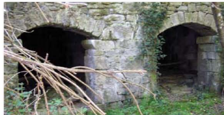
Mulino di S. Angelo. Particolare delle celle dei ritrecini.
