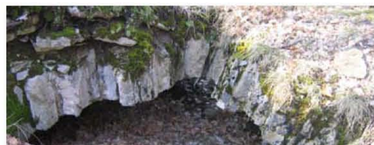
Resti della cisterna del castello di S. Angelo.
